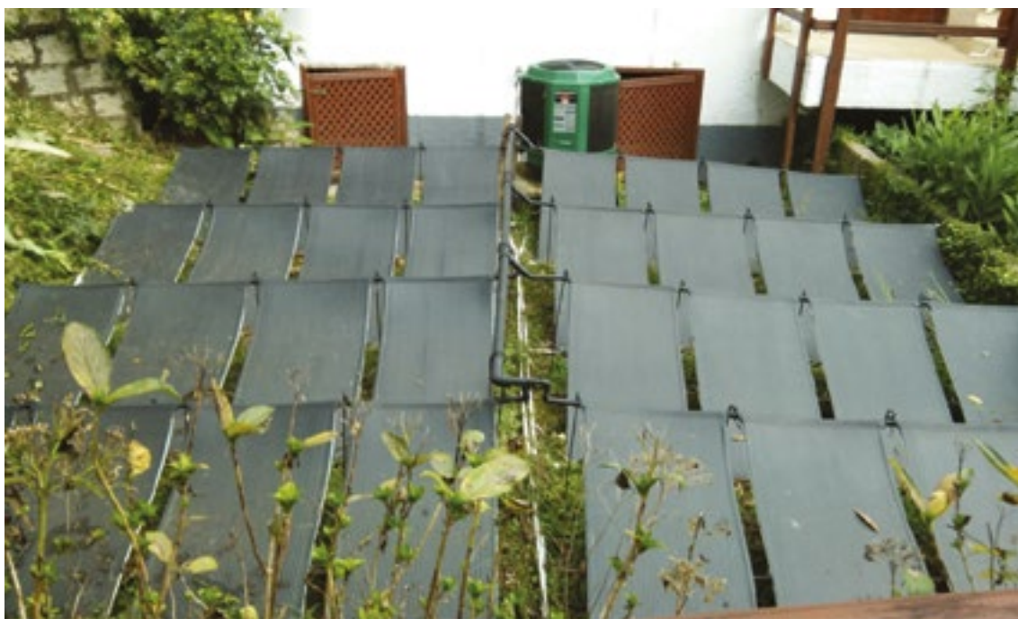
PLACAS SOLARES (AQUECIMENTO DA PISCINA)
